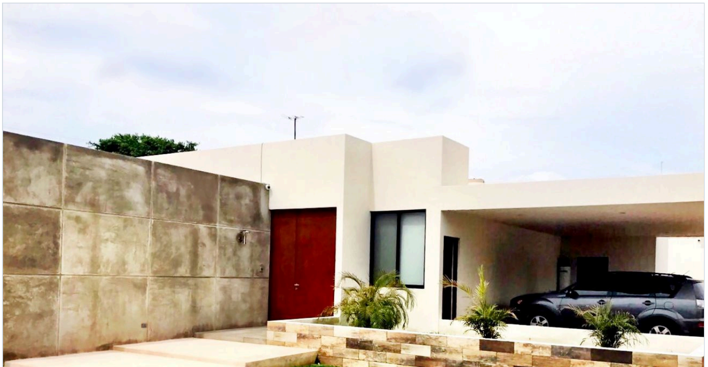
Fig. 7 Vivienda terminada por Urbex.
